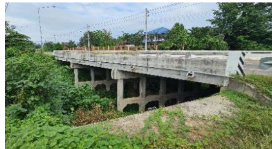
สะพานข้ามคลองสาธารณะ (กม.41+699)
