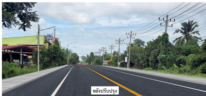
รูปที่ 5.1-5 รูปแบบทางหลวงของโครงการกรณีผ่านชุมชนสำหรับเขตทางกว้าง 15 เมตร บริเวณชุมชนบ้านแก่ง (กม.50+075 ถึง กม.51+215)
