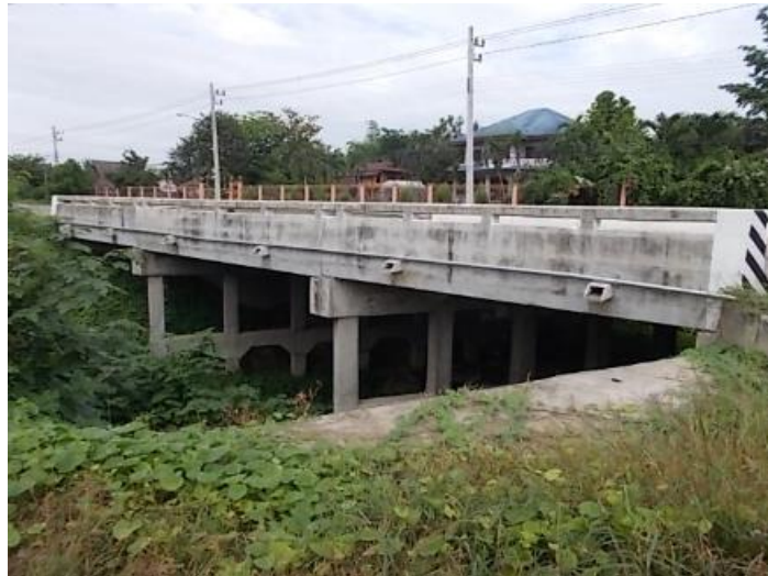
SLAB TYPE สำหรับสะพานที่มีความยาวช่วง 5-12 เมตร
