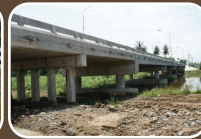
PLANK GIRDER สำหรับสะพานที่ยังมีความยาว 10-12 เมตร
