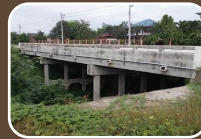
SLAB TYPE สำหรับสะพานที่ยังมีความยาว 5-12 เมตร
