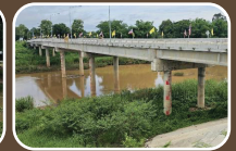
I-GIRDER สำหรับสะพานที่ยังมีความยาวมากกว่า 20 เมตร
