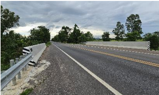
สภาพทั่วไปบริเวณสะพานข้ามคลอง
