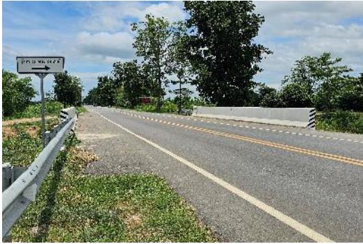
สภาพทั่วไปบริเวณสะพานข้ามคลอง
