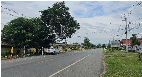
สภาพทางหลวงหมายเลข 102 บริเวณจุดตัด ถนน อบจ.สท.1-0011
