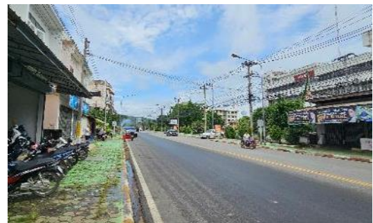
สภาพทางหลวงหมายเลข 102 ช่วงจากจุดเริ่มต้นโครงการถึงสะพานข้ามแม่น้ำยม
