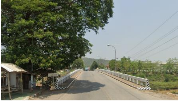
สภาพทั่วไปบริเวณสะพานข้ามแม่น้ำยม
