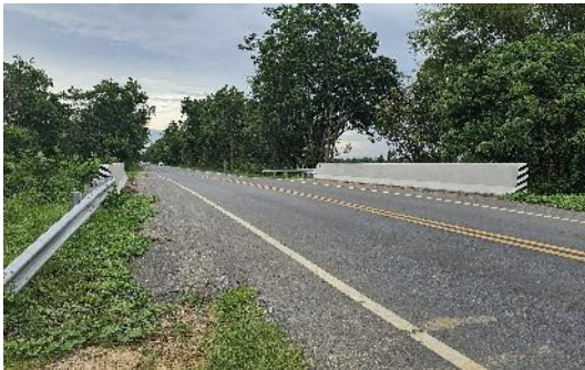
สภาพทั่วไปบริเวณสะพานข้ามคลอง
