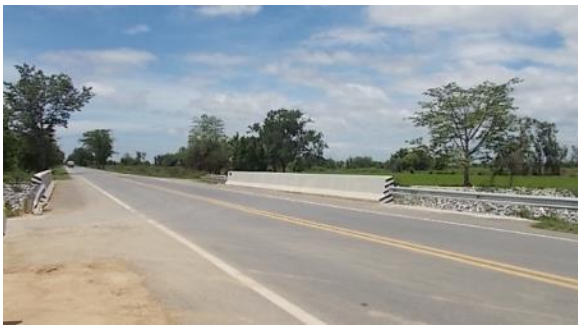
สภาพทั่วไปบริเวณสะพานข้ามคลอง
