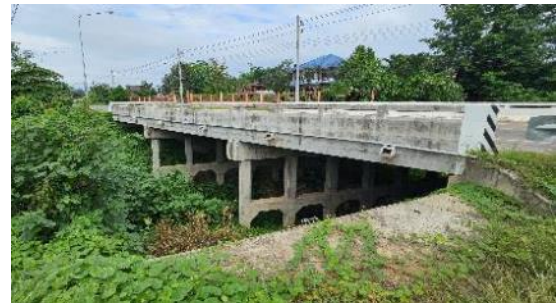
สะพานข้ามคลองสาธารณะ (กม.41+685)
