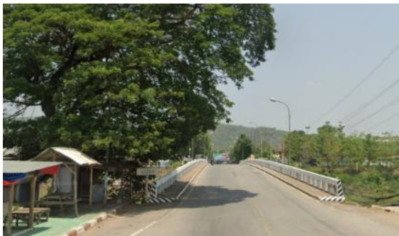
สะพานข้ามแม่น้ำยม
