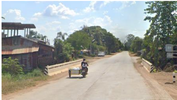
สภาพทั่วไปบริเวณสะพานข้ามคลอง
