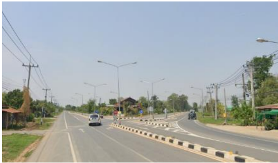
จุดตัดทางแยกถนน ทล.102 กับ ถนน ทล.1404
